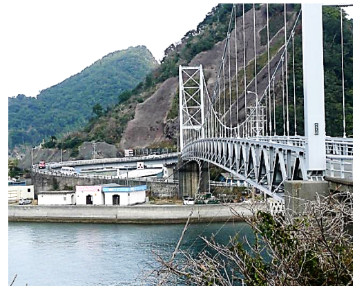
資料8 槌島大橋
