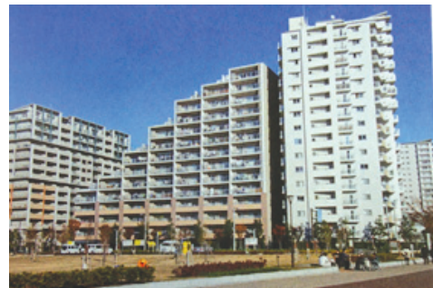
26 図 側面を階段状にして建設されたマンション
